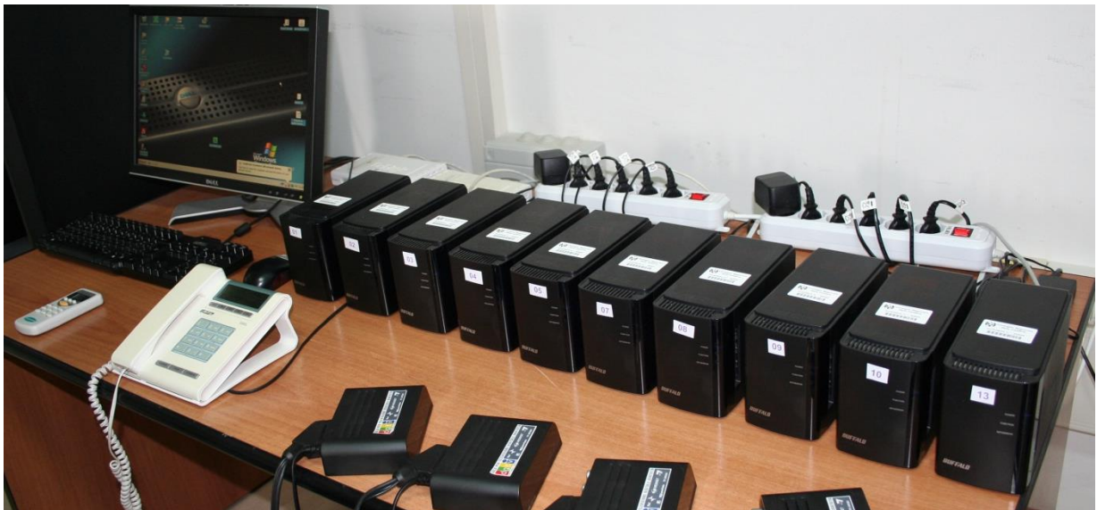
Storage sistema RECorecom – SEDE
